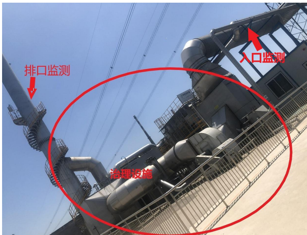
图 7 比较规范的采样设置位置示例
